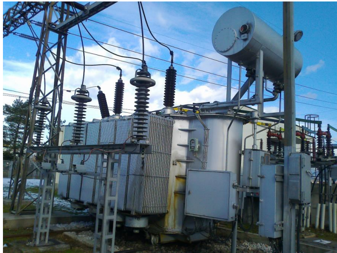
ET 110/10/35 kV u TS Sarajevo 18- prije demontaže i transporta u TS Sarajevo 1
